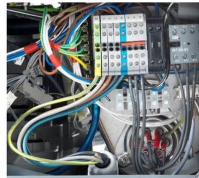
Netzanschlussleitung gemäß Anschlusschema an den Klemmen PE bis N anklemmen. Anschlusschema beachten, das an der Schottwand zum Elektroinstallationsraum angebracht ist
